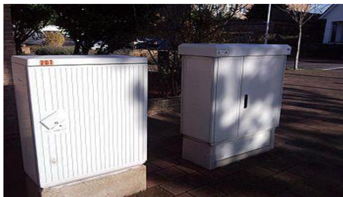
Figuur 7. Kabelverdeelkast (links) en een ROP (rechts)
