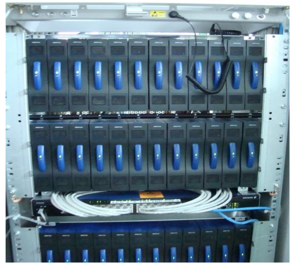
Figuur 14. HVD (links) en DSLAM (rechts)
